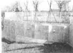
親杭パネル壁工法
