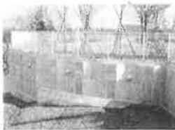
観抗パネル壁工法
