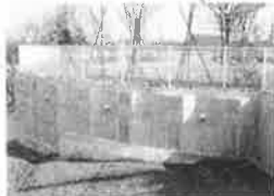
親杭パネル壁工法
