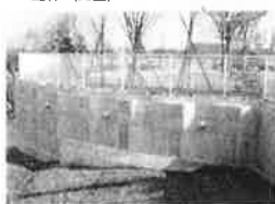
親杭パネル壁工法
