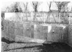
縦杭パネル壁工法
