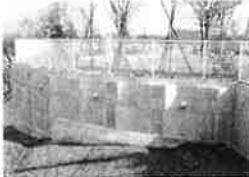
親杭パネル壁工法
