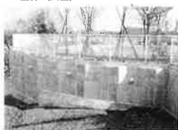
親杭パネル壁工法
